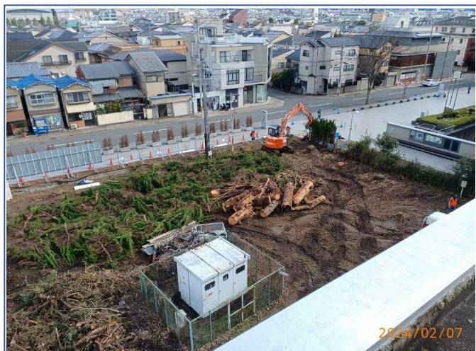
東側:植栽撤去・仮囲い設置
