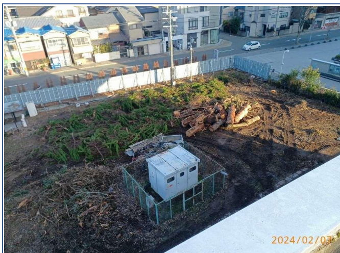
東側:植栽撤去・仮囲い設置
