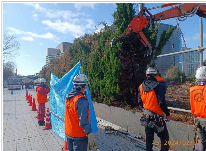
東側:植栽撤去・仮囲い設置
