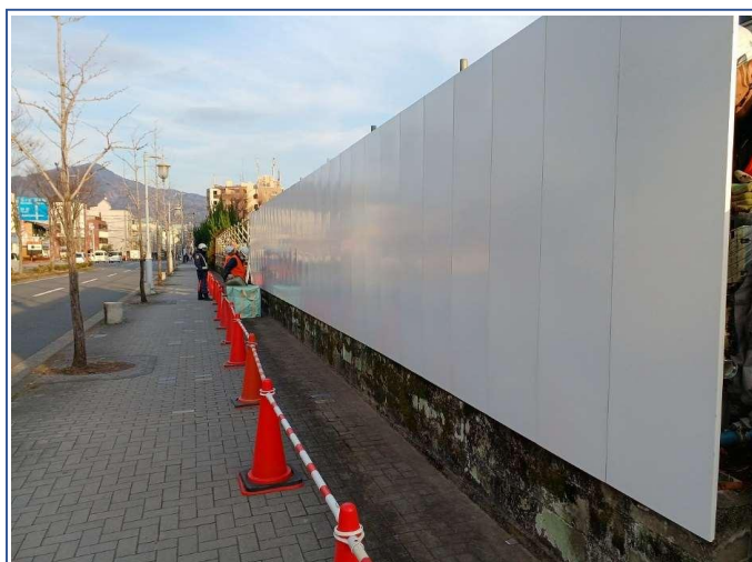
北東側:植栽撤去・仮囲い設置
