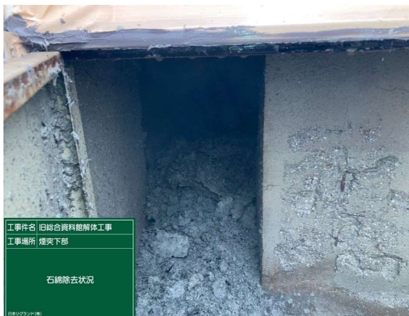
煙突下部:除去完了後袋詰め
