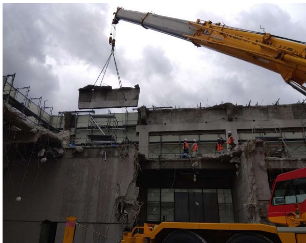
3F外壁撤去(南側 吊切り)
