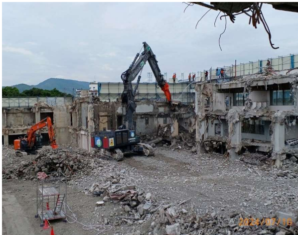
3F外壁撤去(南側 吊切り)
