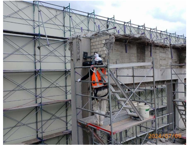
3F外壁撤去(南側 吊切り)
