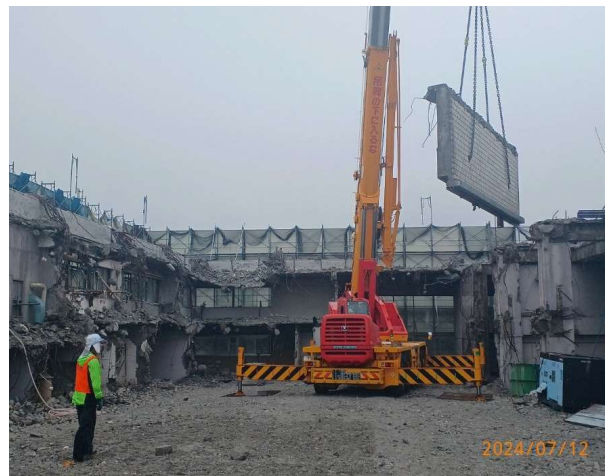
3F外壁撤去(南側 吊切り)
