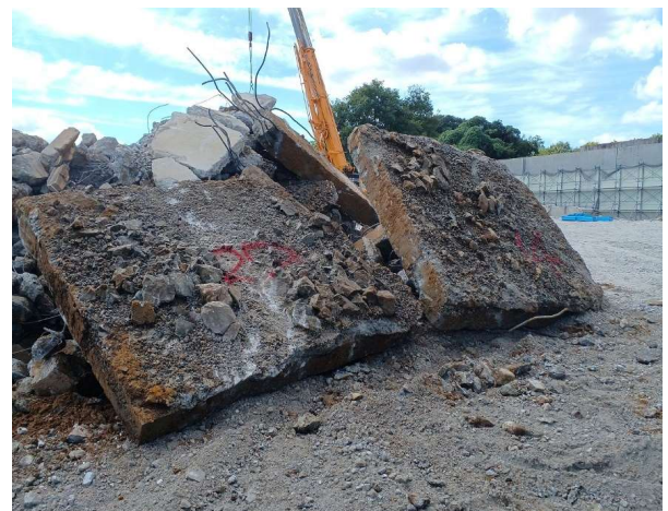
基礎撤去後埋め戻し
