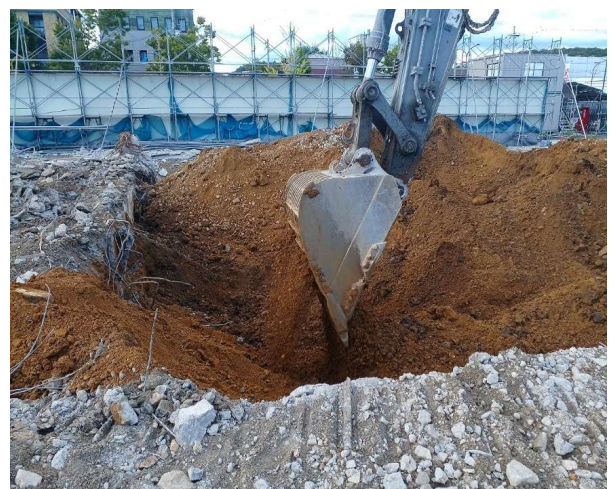
基礎撤去後埋め戻し
